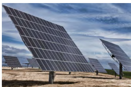
新能源 Green Energy
